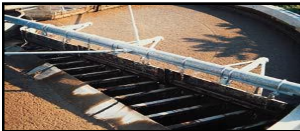
Figure 2 : Etape d'épaississement des boues par flottation(ADDEME,1999)
