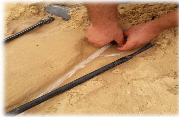
Fig. n ° 20: Installation du système d'arrosage
