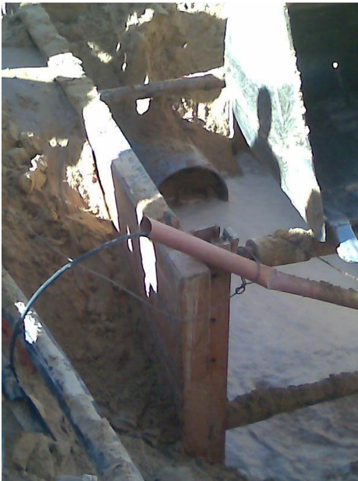
Photo V-4 : la pose de la canalisation.
