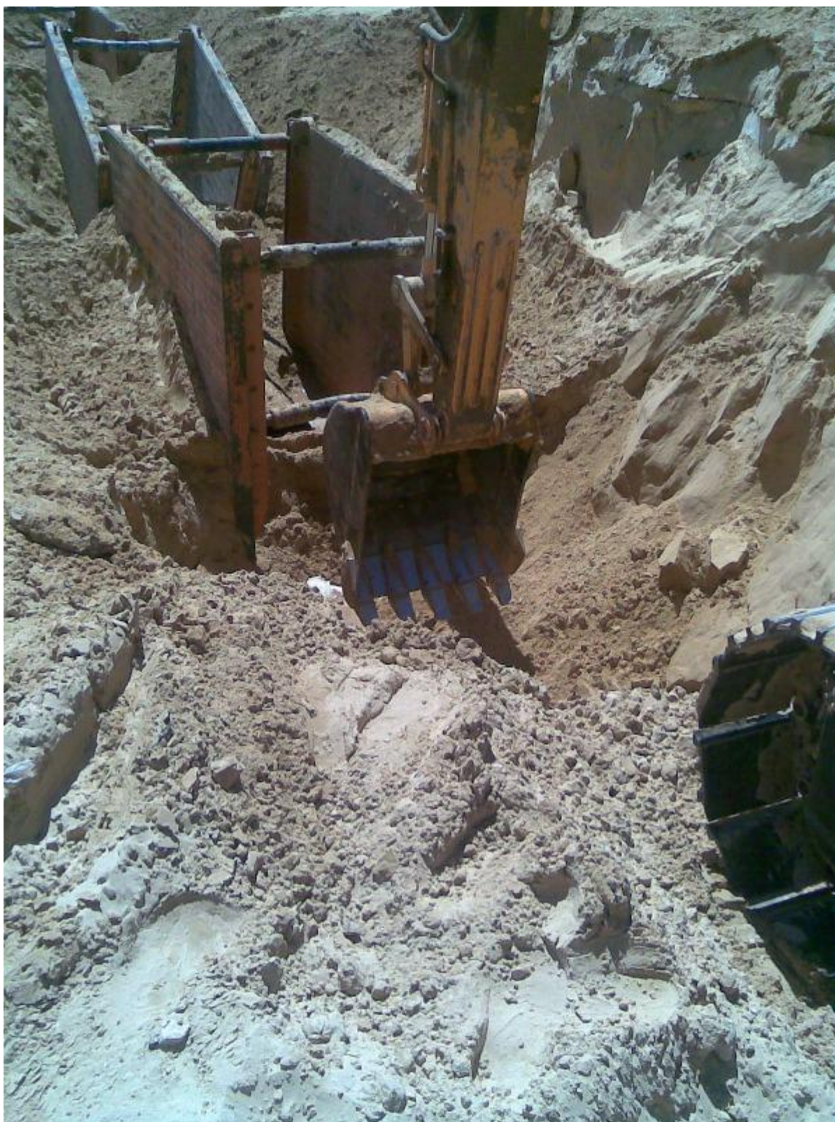
Photo V-2 : Excavation de la tranchée
