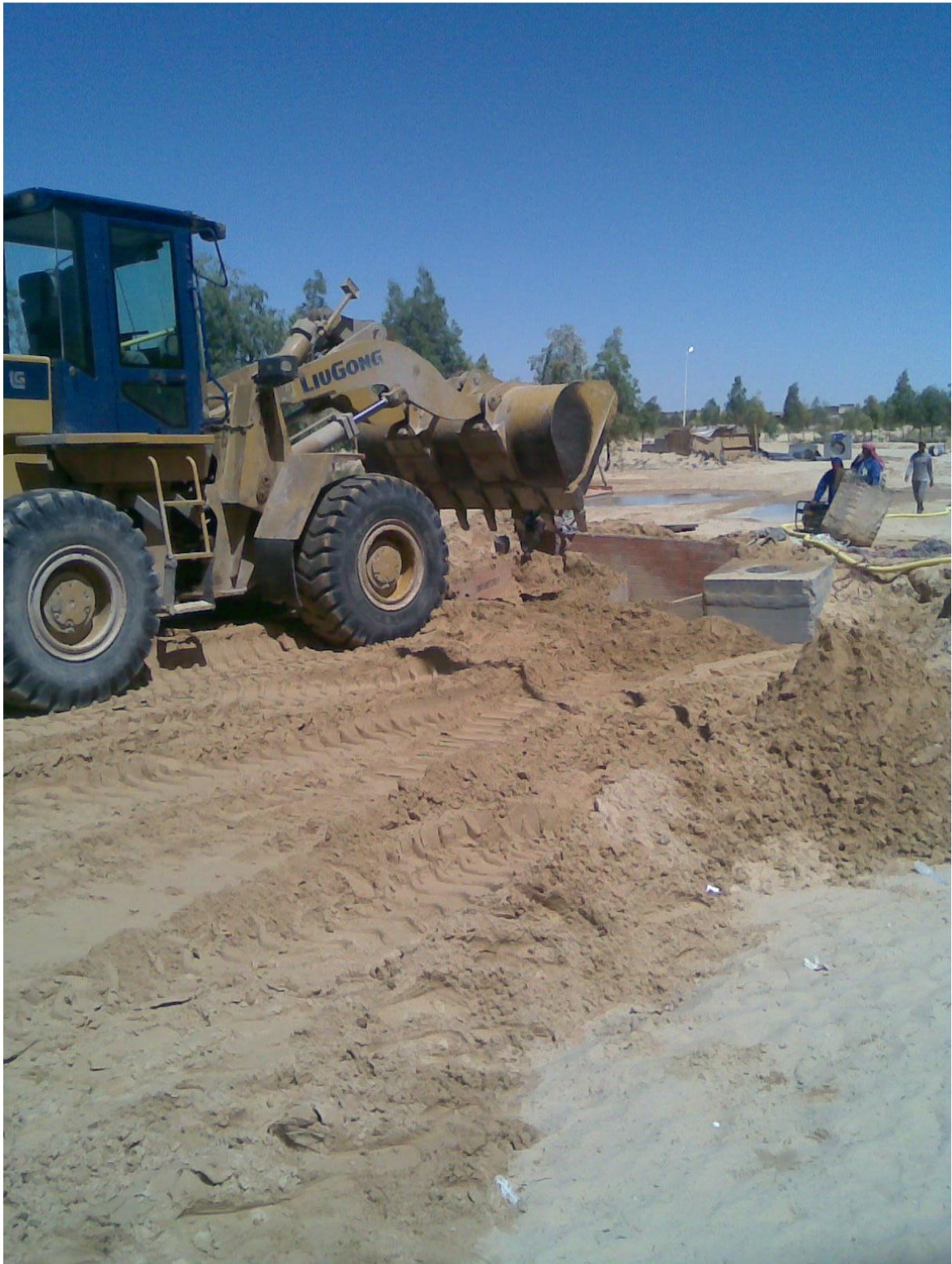
Photo V-5 : remblaiement de la tranchée
