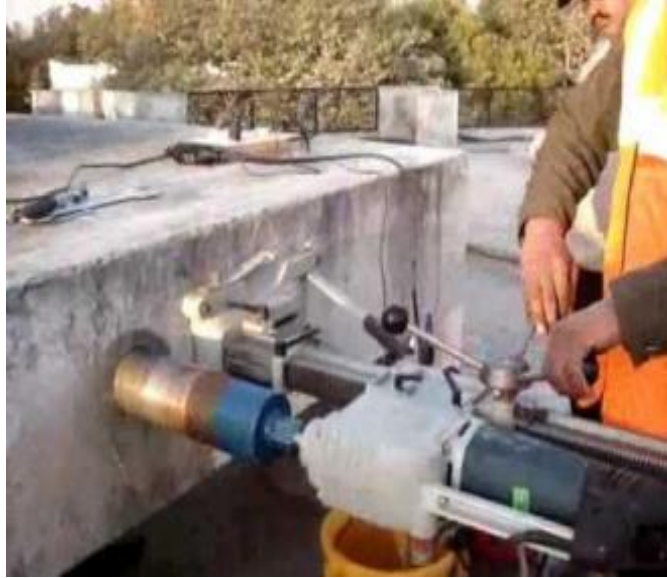
Photo.I.1 : Le carottage du béton
