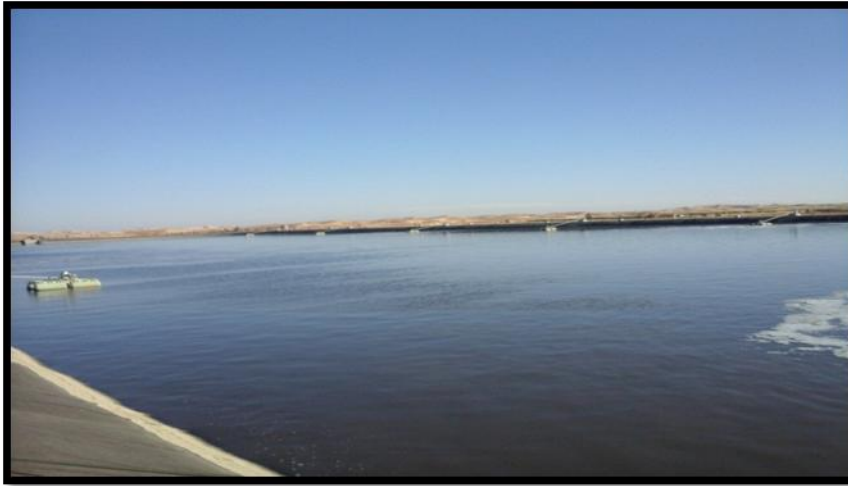
Photo. N°:( IV. 05): 2ème phase de lagunage aéré (B .B2 .B3)
