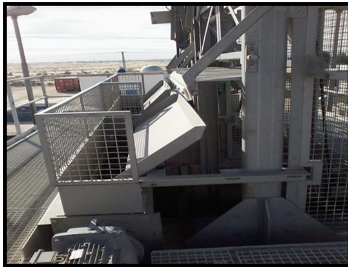
Photo. N°:( IV. 01): Technique dégrillage
