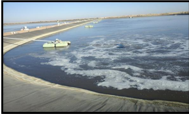
Photo. N°:( IV. 03): La première phase de lagunage aéré (A1, A2, A3)
