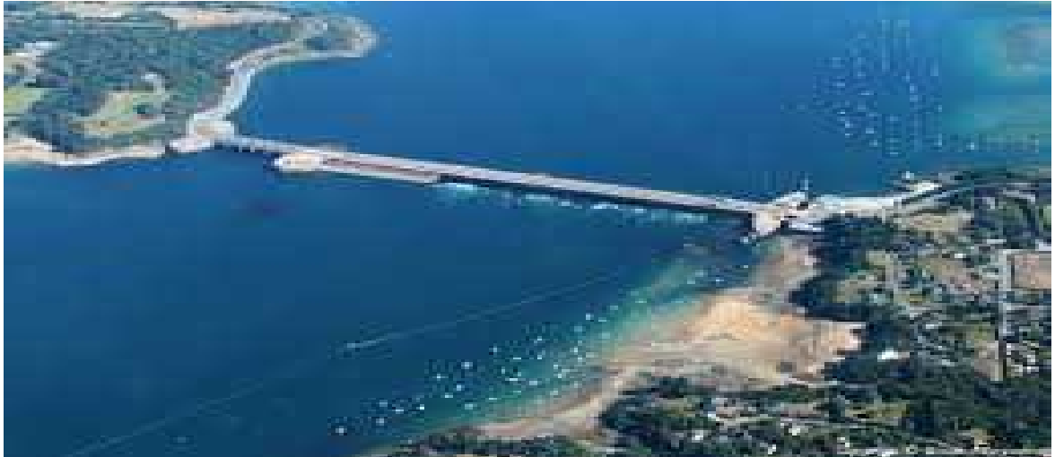
Figure I.7 : Usine marémotrice de la Rance 240 MW
