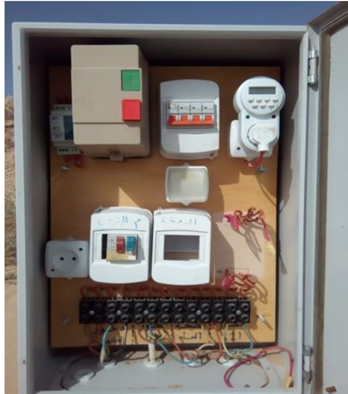
Figure I.20 L'armoire de commande de deux pivots et un groupe motopompe
