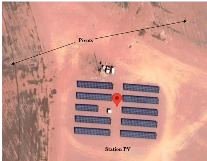
Figure IV.6 La nouvelle station PV destinée à alimenter deux pivots
