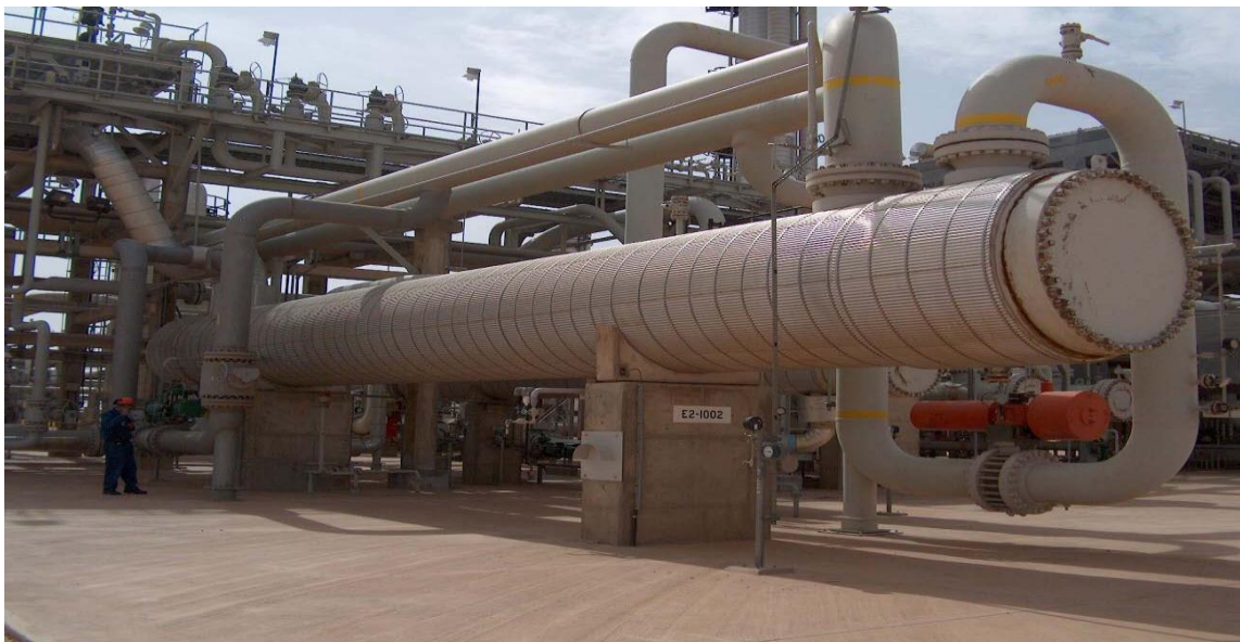
Fig. IV.3 : Exemple d'un échangeur tubulaire .
