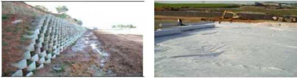
Figure (2.13) : Pose des géotextiles de renforcement.
