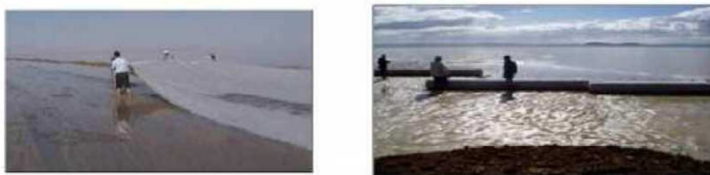
Figure (2.11) : pose des géogrilles de séparation.
