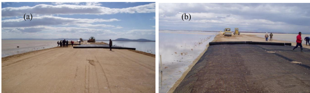
Figure (4.10): Pose de nappe de géotextile directement sur le sol de sebka : (a) état sec ; (b) état inondé[10]
