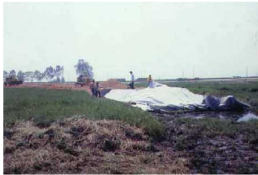
Figure (2.23) : Construction d'une route non revêtue sur une argile organique molle.
