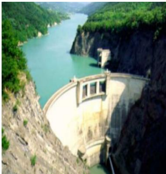
Figure I.11 : Exemple d'un Barrage voûte (barrage de St-Pierre Cognet)[6]
