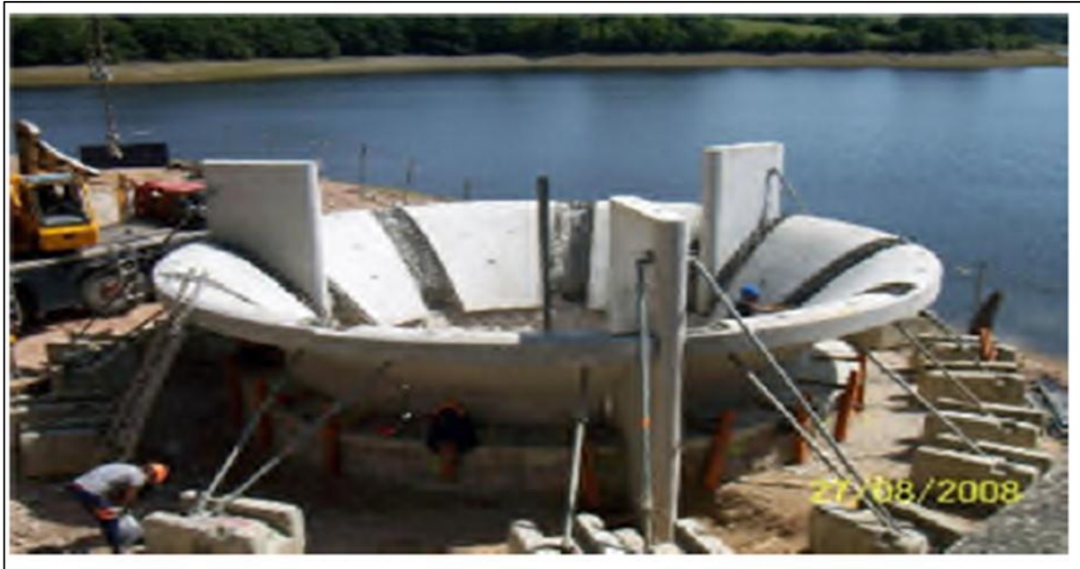
Figure I.23: Évacuateur en puits circulaire.(de Google)
