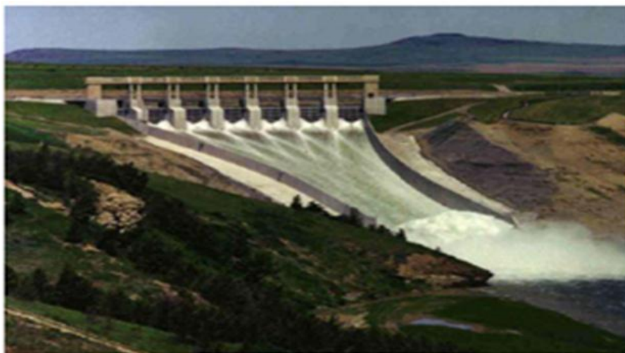
Figure I.17 : Évacuateur de crues de surface.(de Google)
