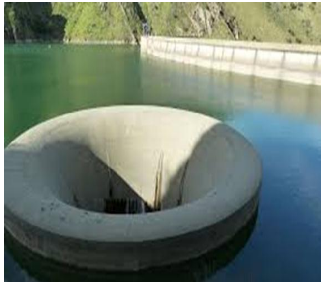
Figure I.20 : Évacuateur de crues en charge.(de Google)
