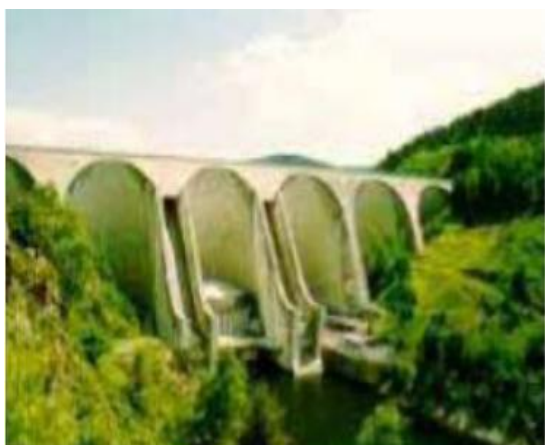
Figure I.10 : Barrage à contre fort (Grandval)[7]
