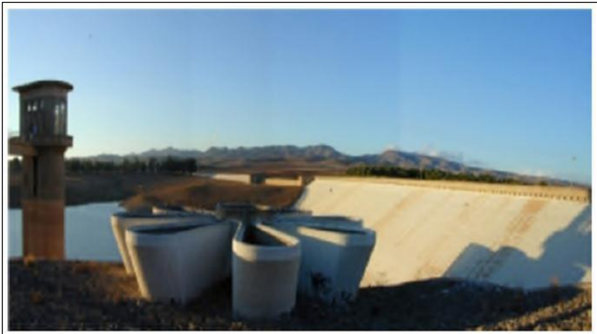
Figure I.24 : Evacuateur en puits marguerite.(de Google)
