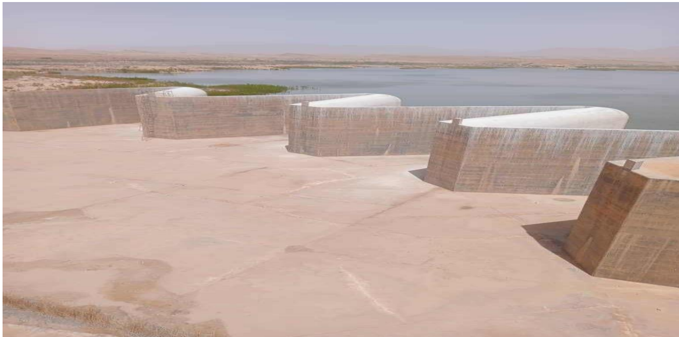
Figure II. 7:Evacuateur de crues[Photo prise depuis le téléphone ]
