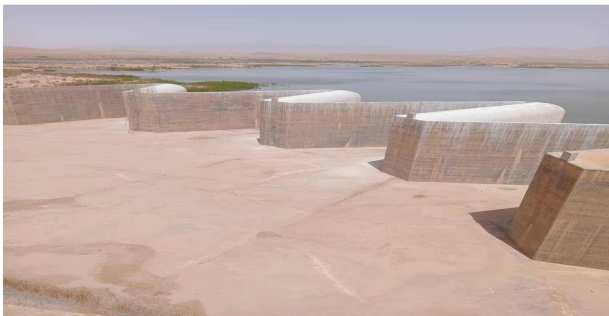
Figure6:Évacuateur de crues
