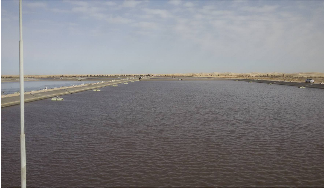
Figure IV.4: photo de Lagune aérée (station Kouinine).
