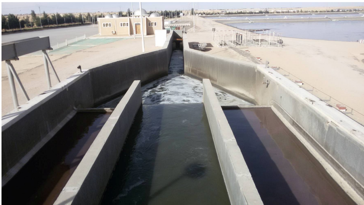
Figure IV.3: photo Dessableur (station Kouinine).
