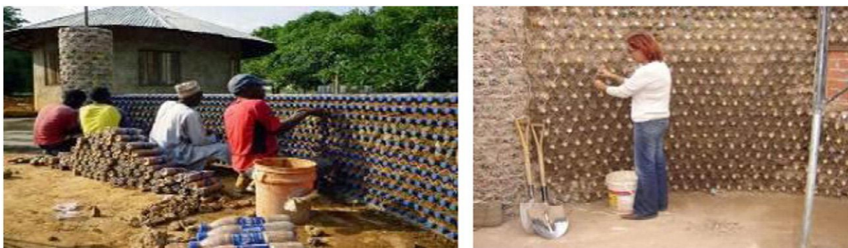
Fig.III.6. Utilisation de bouteilles de plastique dans le bâtiment.
