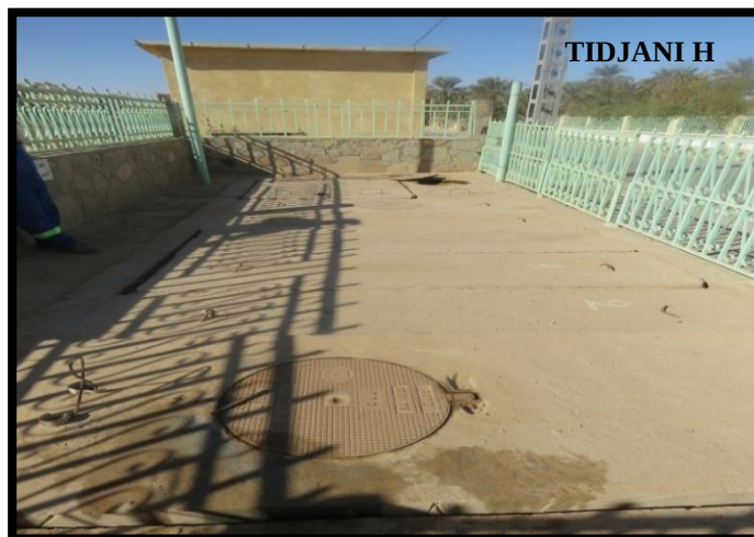
Figure N°06: La fosse septique de la STEP Temacine
