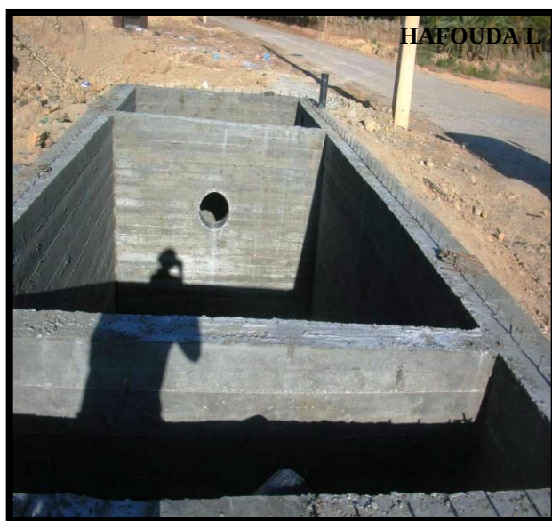
Annexe N°05:les compartiments de la fosse septique
