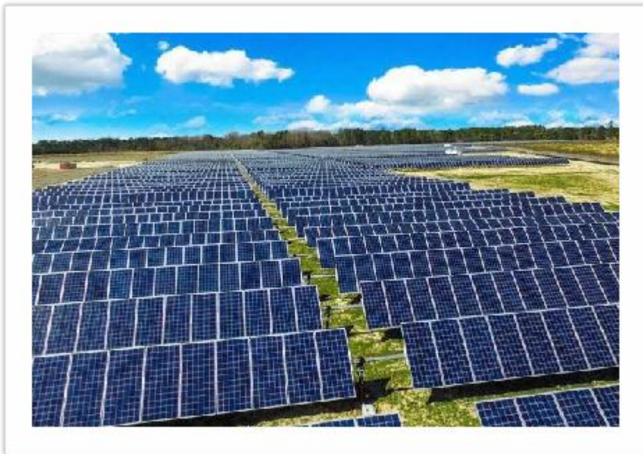
Photo I.3: Exemple sur les capteurs plans d'énergie solaire.
