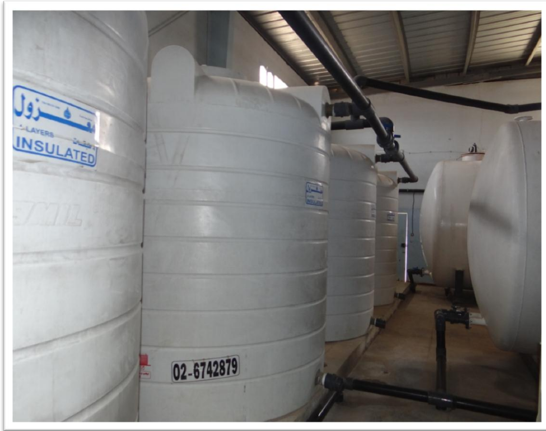
الصورة (3 - 02) : توضيح خزانات الترسيب
