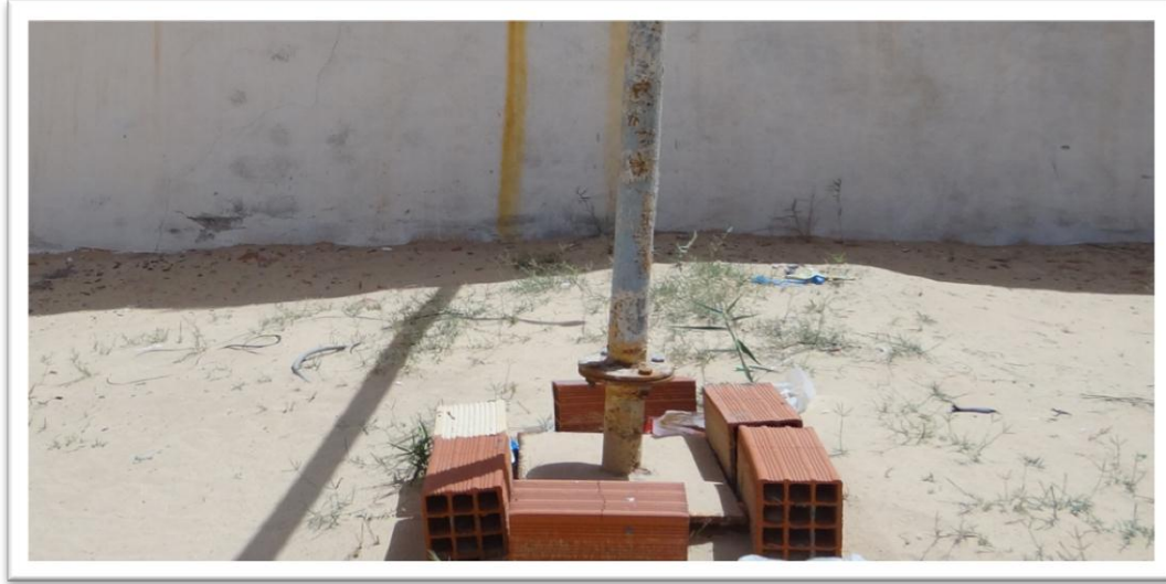
الصورة ( 3 - 01 ) : توضيح بئر الاستخراج
