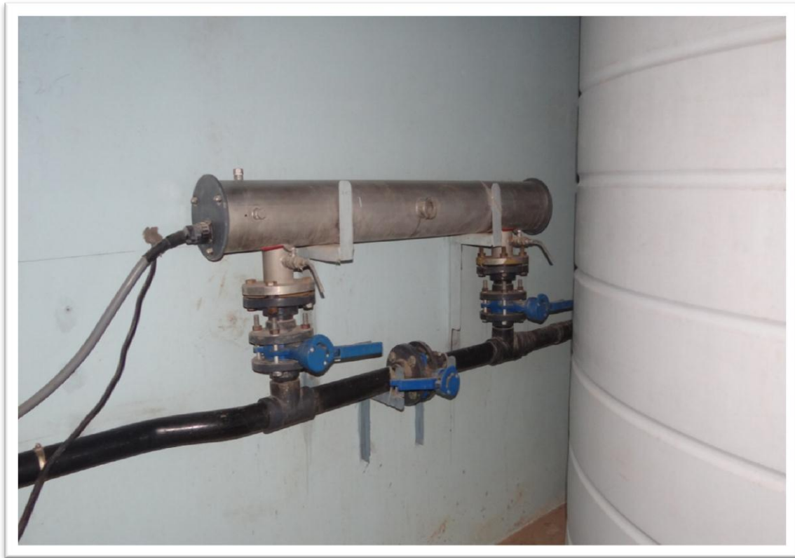
الصورة (3 - 12) : توضيح جهاز التطهير بالأشعة
