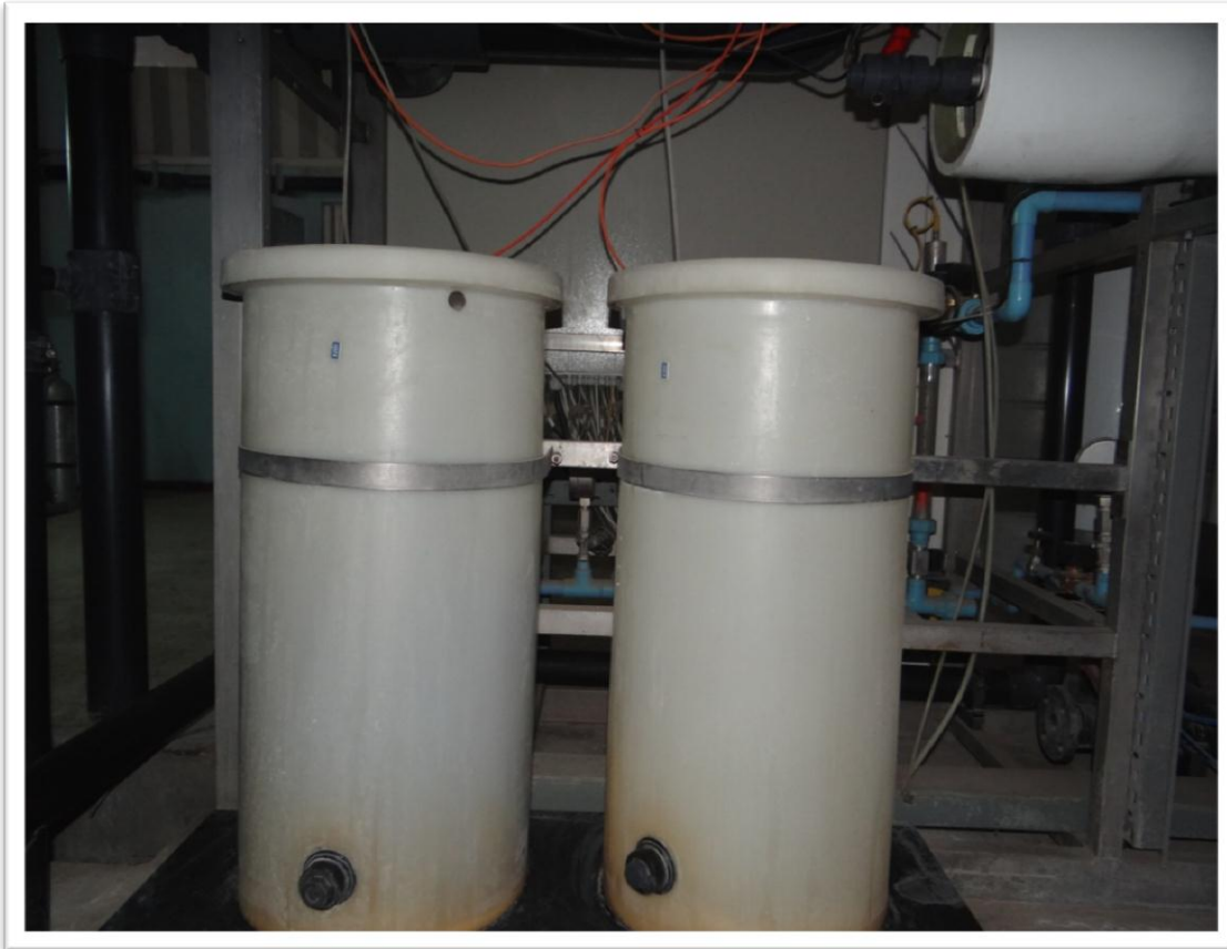
الصورة (3 - 07) : توضيح خزان لإضافة الكلور
