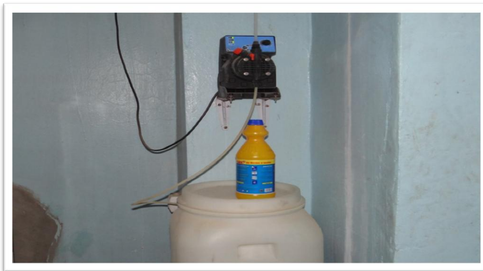
الصورة (3 - 14) : توضح مرحلة التطهير بالكلور قبل التوزيع
