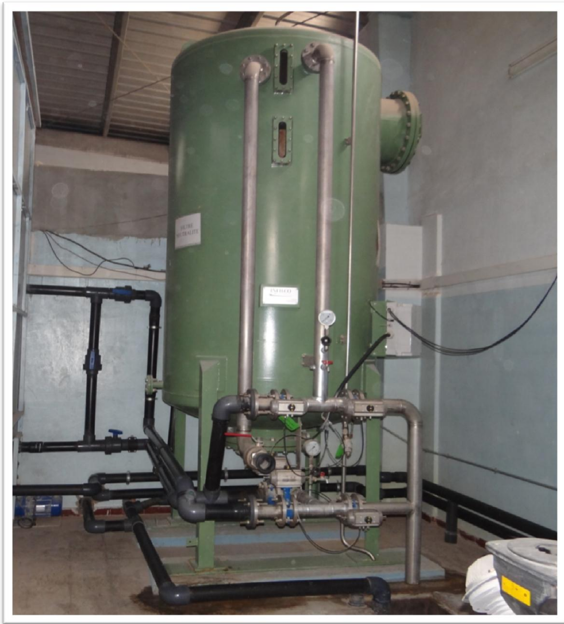
الصورة (3 - 11) : مصفاة طبيعية لتثبيت وإعطاء النكهة للماء
