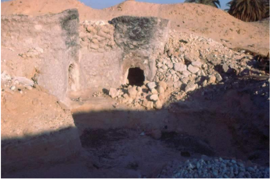
فرن تقليدي لصناعة جبس البناء على حافة غوط النخيل في وادي سوف
