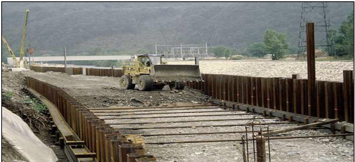
Photo I.7 : Rideaux de palplanches métalliques( Al Kashi 2011)
