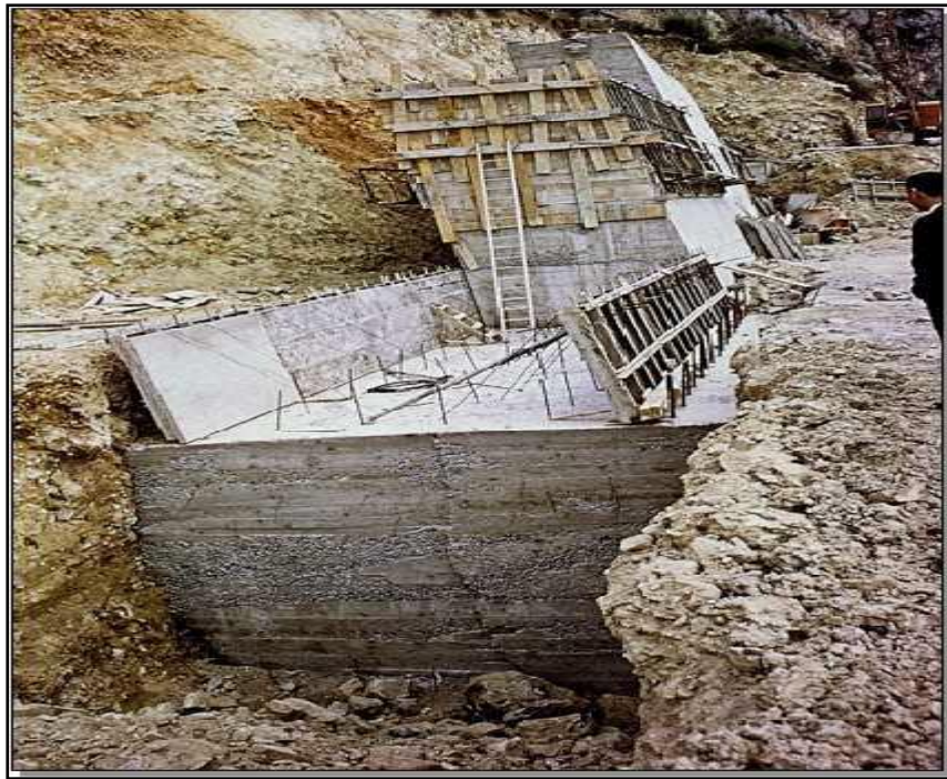
Photo I.3 : Murs poids en béton ( Jérôme Saliba 2017)
