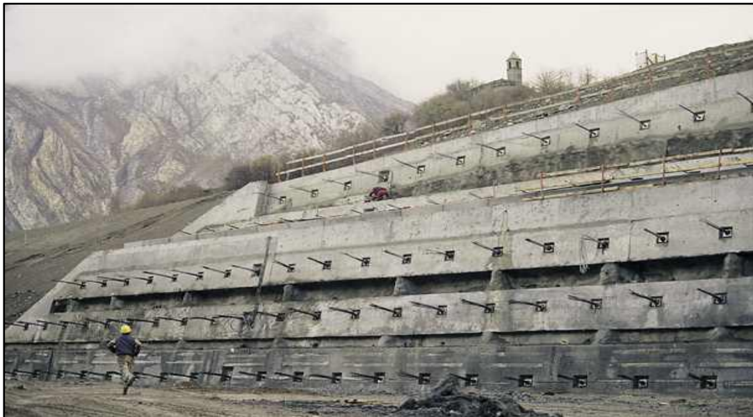
Photo I.17 : Poutres ancrées en phase de construction ( Al Kashi 2011)
