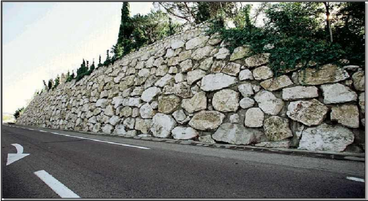
Photo I.2 : . Murs poids en maçonnerie jointoyée (lycee-cherioux.fr/2017)
