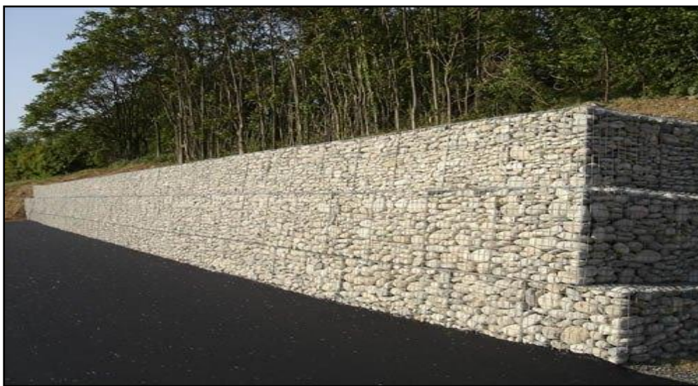
Photo I.4 : Murs poids en gabions (Adrien Lafond 2012)
