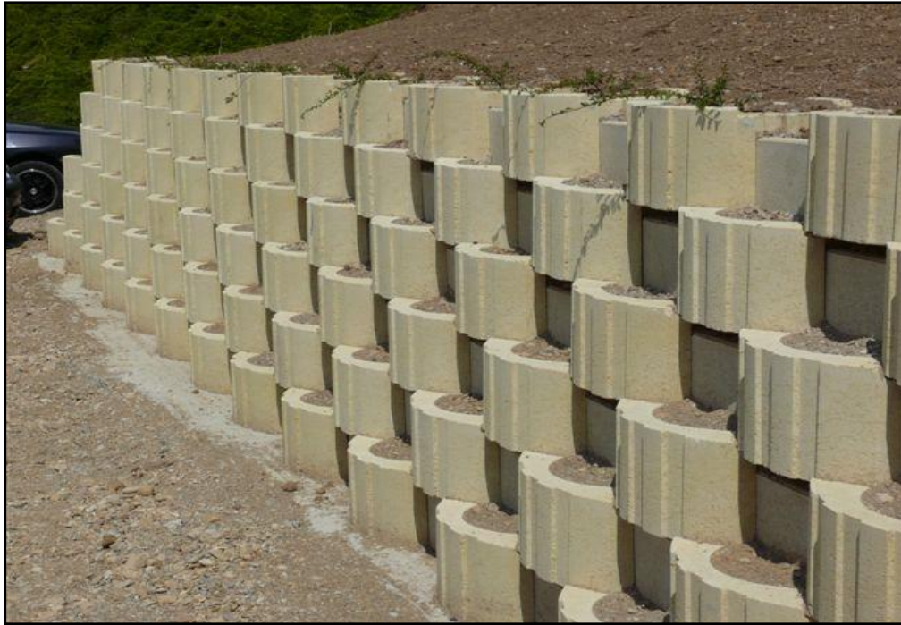
Photo I.5 : Murs poids en éléments préfabriqués en béton empilés (chris 2009)
