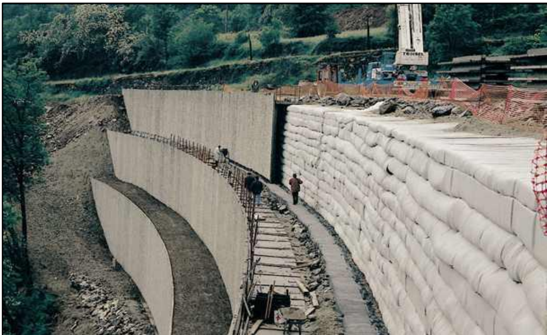
Photo I.14 : Procédé Ebal-Géotextiles : parement préfabriqué devant le massif en géotextile (Al Kashi 2011)
