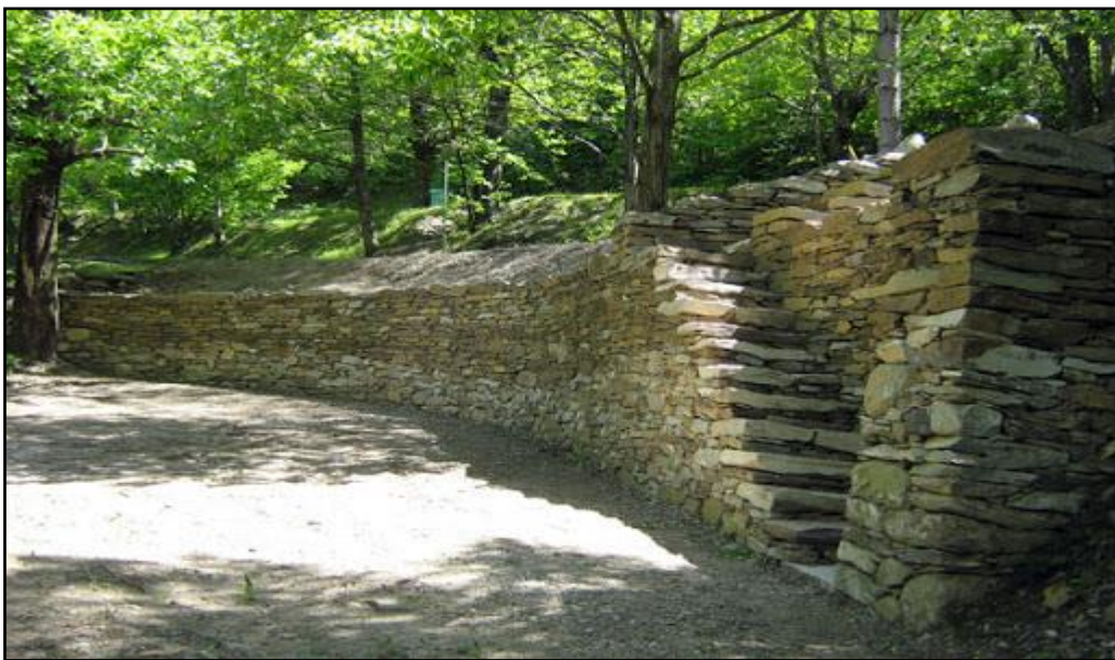
Photo I.1 : Murs poids en maçonnerie de pierres sèches(lycee-cherioux.fr 2017)
