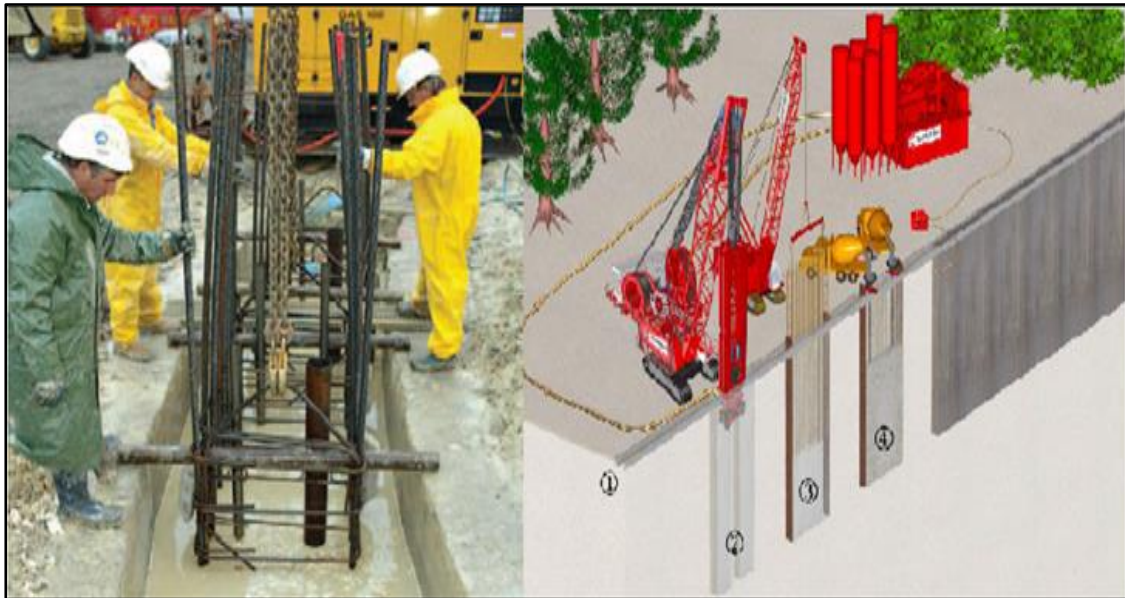
Photo I.8 : La paroi moulée ( Khemoum 2017 )
