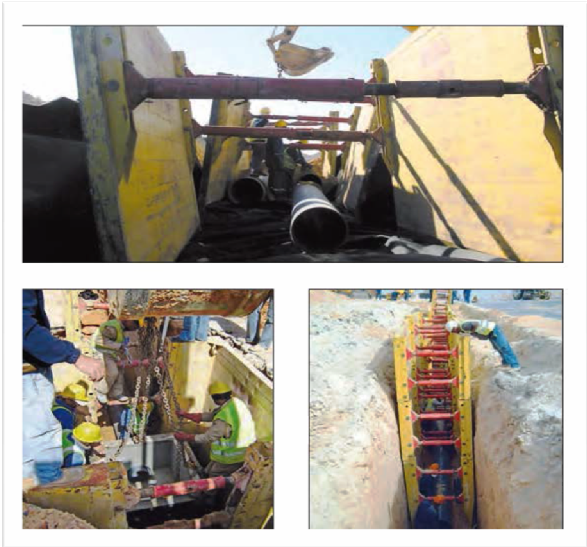
Photo VII.1-Blindage des tranchées avec la mise en place de la conduite et le regard
