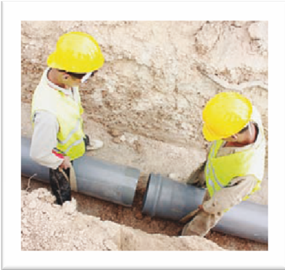
Photo VII.3 Pose des canalisations en tranchée
