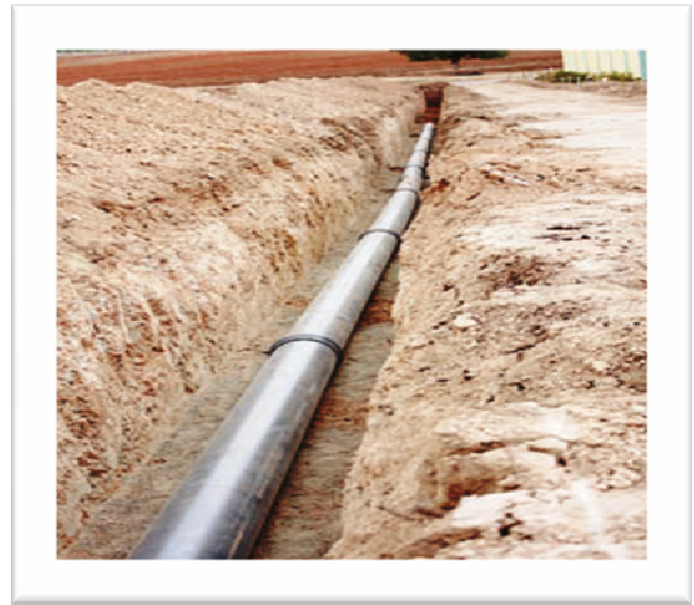
Photo VII.3 Pose des canalisations en tranchée
