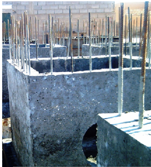
Photo VII.4 Réalisation du regard
