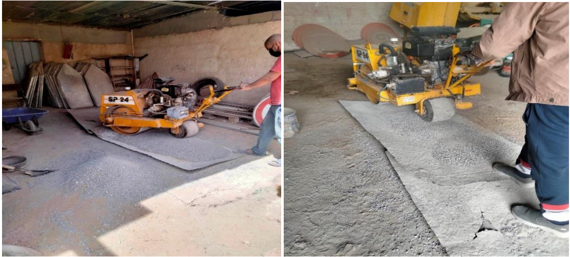
Figure 2.20: Le broyage par un compacteur cylindrique
