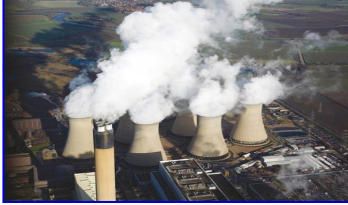
الشكل (I-12): محطة الطاقة Drax التي تعمل بالفحم في المملكة المتحدة والمزودة بأنظمة إزالة الكبريت، والتي تم تركيبها عامي 1993 و1996 [18].
