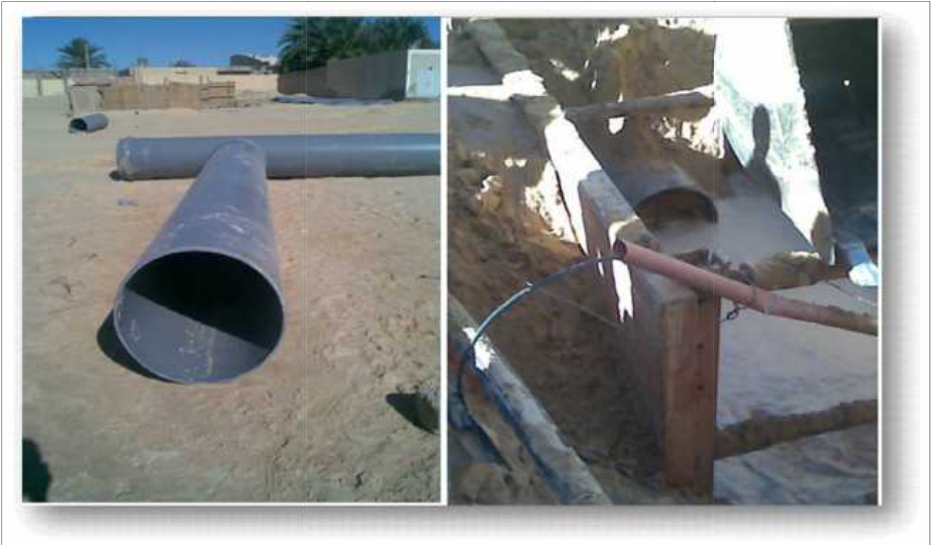
Figure V.3 : Pose des canalisations
