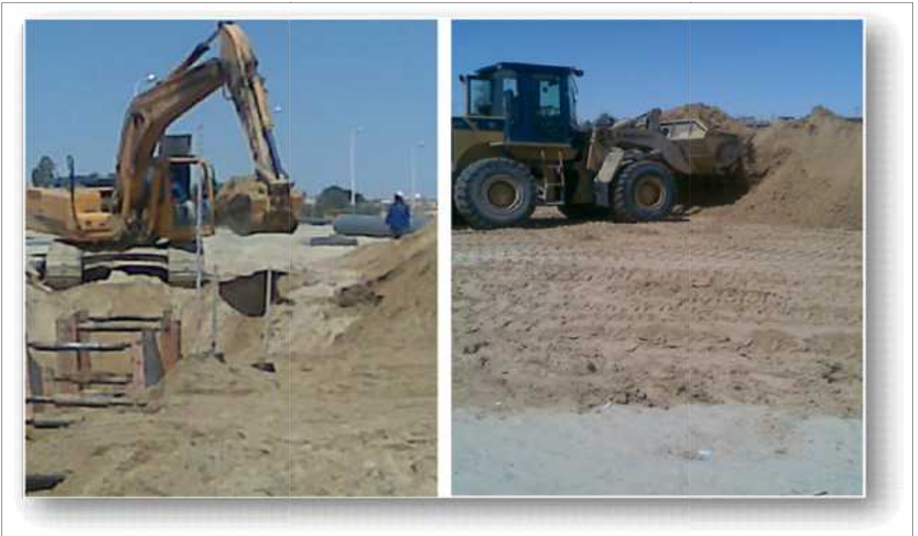
Figure V.2. Exécution et terrassement des tranchées
