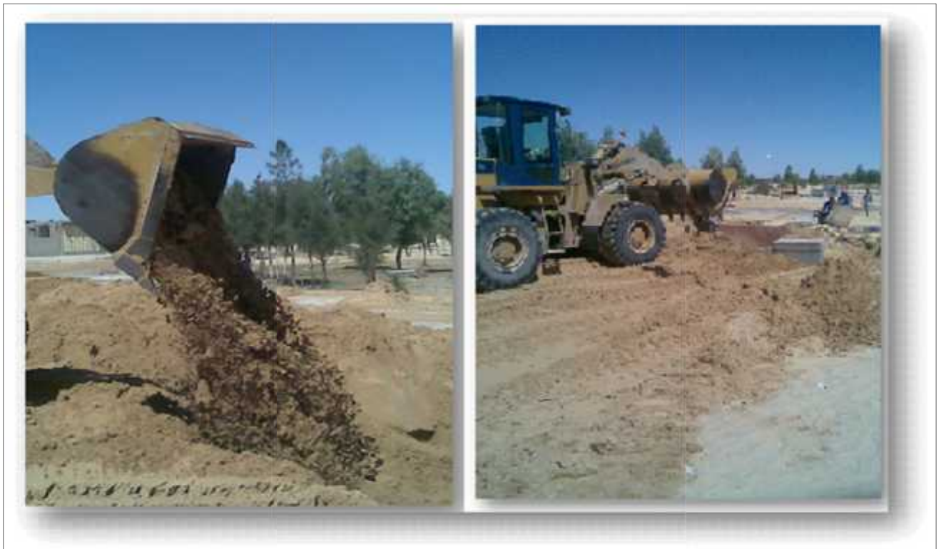
Figure V.4 : Remblaiement des tranchées
