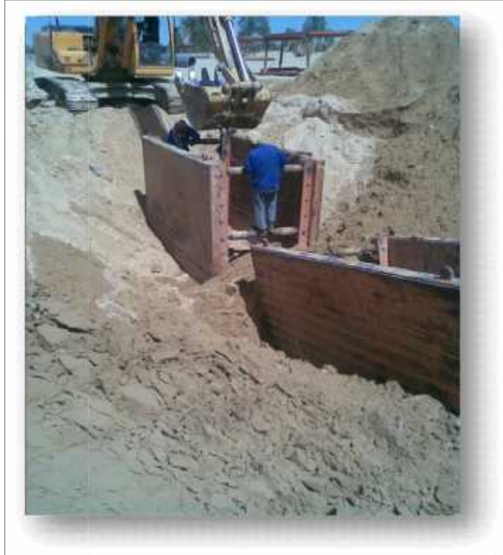
Figure V.1. La protection contre les éboulements
