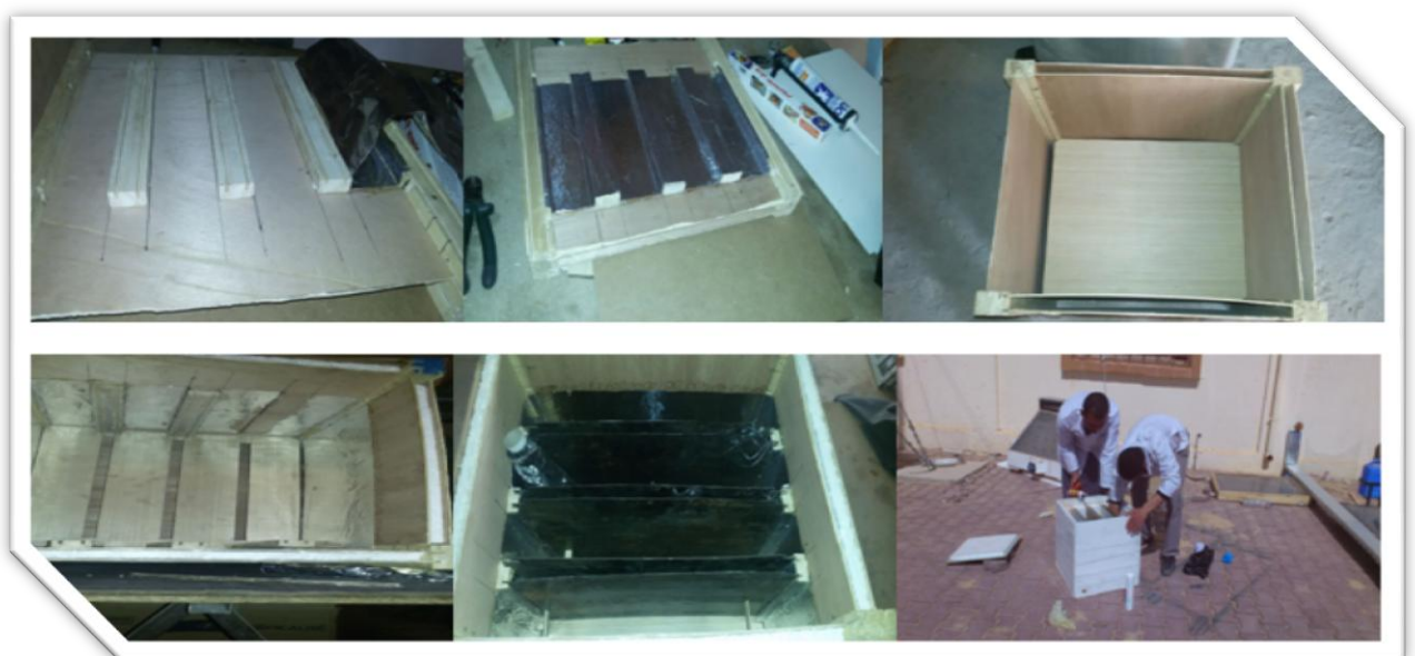
Figure IV.7: l'image montre les étapes fabrication du l'unité de stockage
