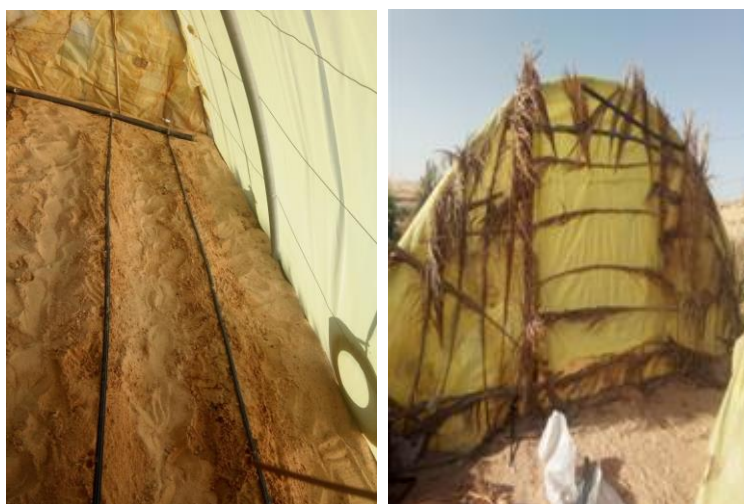
Figure 25. Montage de la serre et installation du système d'irrigation (Originale, 2020)
