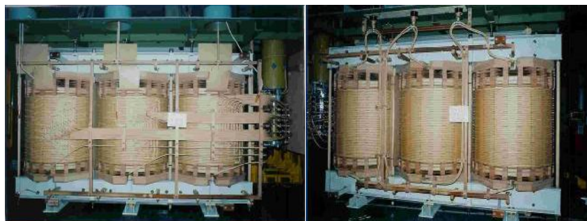
Figure I 4. Partie active vue coté BT Figure I 3. Partie active vue coté HT
